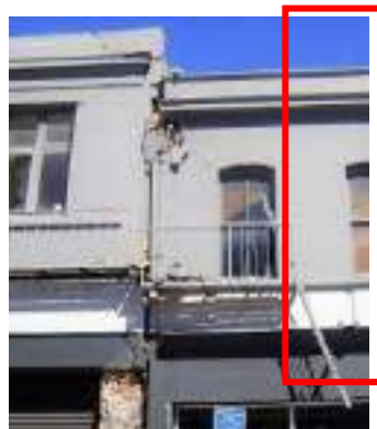
Figura 17. Condición de Golpeteo en Estructuras
