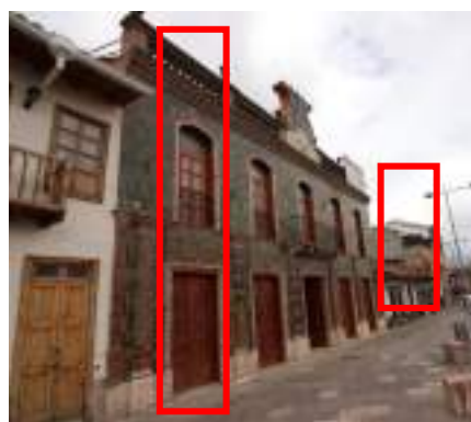
Figura 18. Condición de adyacencia en Estructuras
